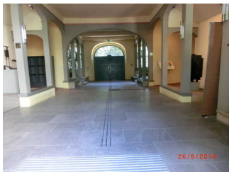
Leitsystem zwischen den beiden Eingängen
