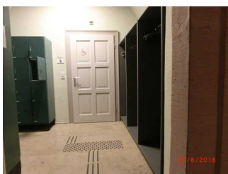
WC-Tür und Wegeleitsystem
