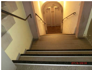
Treppe zum WC im Untergeschoss
