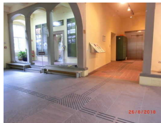
2 Stufen oder Rampe zu Kasse, WC und Aufzug mit Leitsystem
