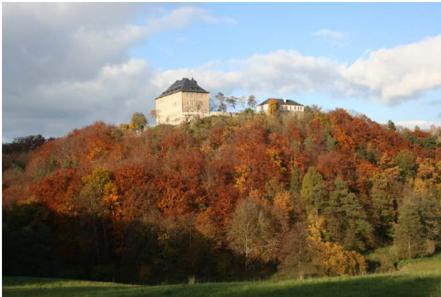
Abb. Reste der mittelalterlichen Burg Brandenstein sind zum Teil im barocken Baukörper des Schlosses und in dessen Außenanlagen integriert.
